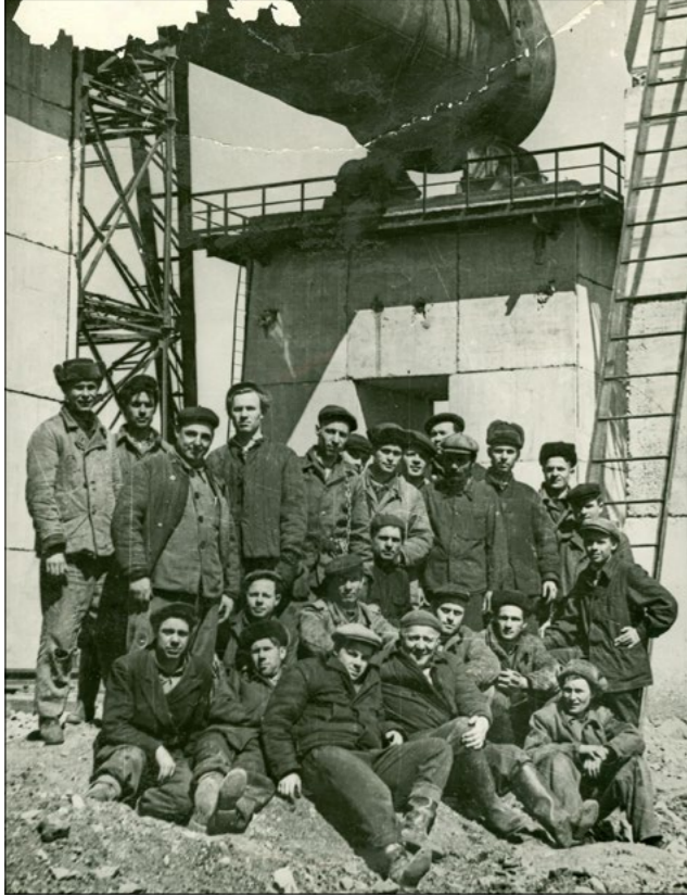
Бригада монтажников на строительстве цементного завода в г. Новоульяновск. 1959 г. ГАНИУО. Ф.162. Оп. 2. Д.775. Л.1. Подлинник.
