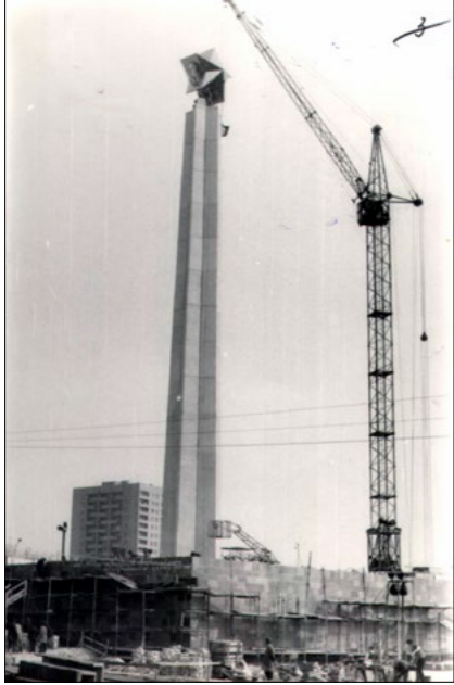
Строительство обелиска Славы в г. Ульяновске. 1975 г. ГАНИУО. Ф. 5968. Оп. 1. Д. 677. Подлинник.
