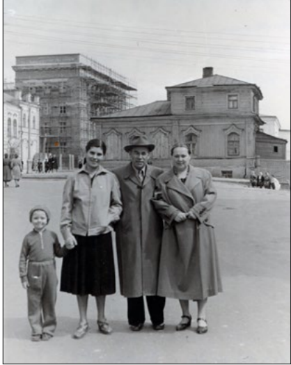
Строительство здания Ульяновского обкома КПСС в г. Ульяновске. 2 мая 1958 г. ГАНИУО. Ф. 6225. Оп. 1. Д. 12. Л. 1. Подлинник.
