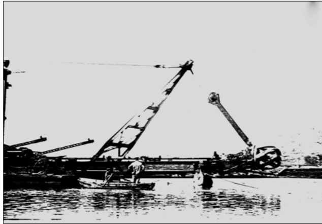
Строительство дамбы. 1950-е гг. Подлинник.
