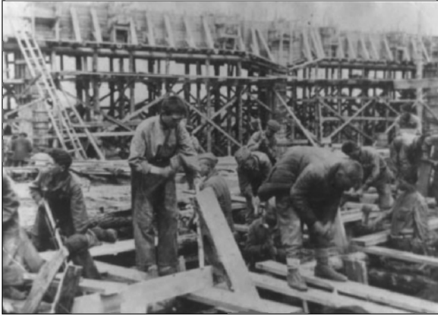
Строительство опалубки Ульяновского автомобильного завода. 1944 г. ГАНИУО. Ф. 5968. Оп. 1. Д. 465. Подлинник.
